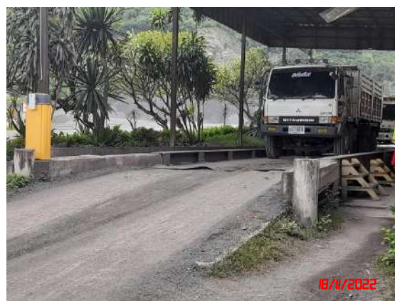
รูปที่ 11 จุดชั่งน้ำหนักรถบรรทุกแร่
